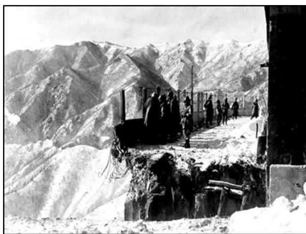
圖11 美軍工兵部隊正在查看被炸斷的水門橋 資料來源：kk資訊網，〈美軍工兵是如何修復水門橋〉， https://kknews.cc/entertainment/3643oya.html ，檢索日期：西元2022年3月20日。
