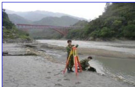
圖 12 疏浚河道現地測量
