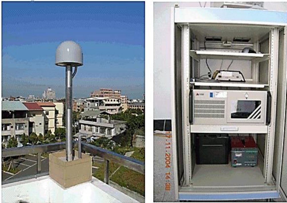
鋼柱式天線架基座架設及儀器機櫃主要基本配備實景相片
