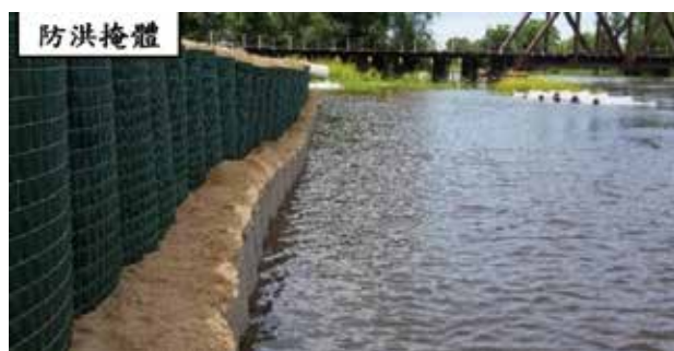
圖5 運河運用掩體設置防洪屏障圖
