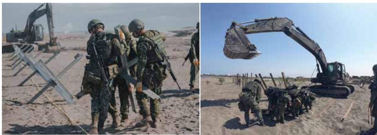
圖2 工兵部隊灘岸阻絕設置圖(a)漢光37號南部地區海灘(b)工兵部隊基地測考紀實。
