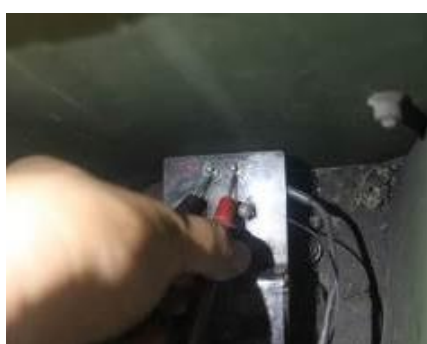
圖9 量測繼電器
