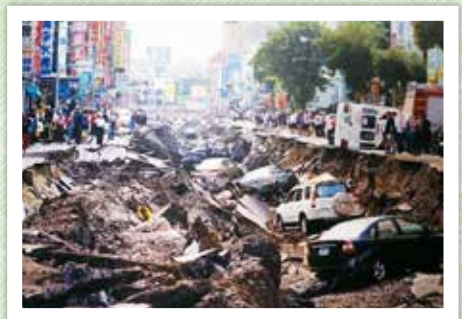
圖12 高雄氣爆造成嚴重災損
