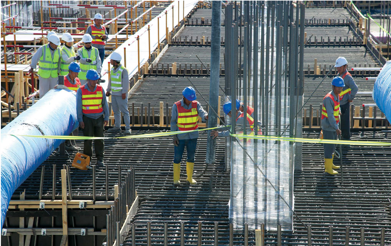
2019年9月22日，工人在位於土耳其阿達納(Adana)之「胡努特魯熱能電廠」(Hunutlu Thermal Power Plant)施工現場工作的情形；該電廠係中共在土耳其的最大直接投資項目。這項耗資17億美元，並由「上海電力公司」(Shanghai Electric Power Company)領頭的投資項目，乃是連接中共提出之「一帶一路倡議」及「土耳其中間走廊」(Turkey's Middle Corridor)的旗艦計畫。(Source: Xinhua/Zheng Siyuan)
