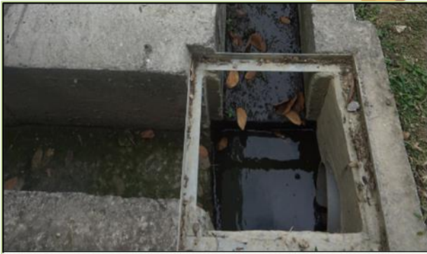
圖10 陰井沉澱簡易廢(污)水處理 資料來源：作者自行拍攝。
