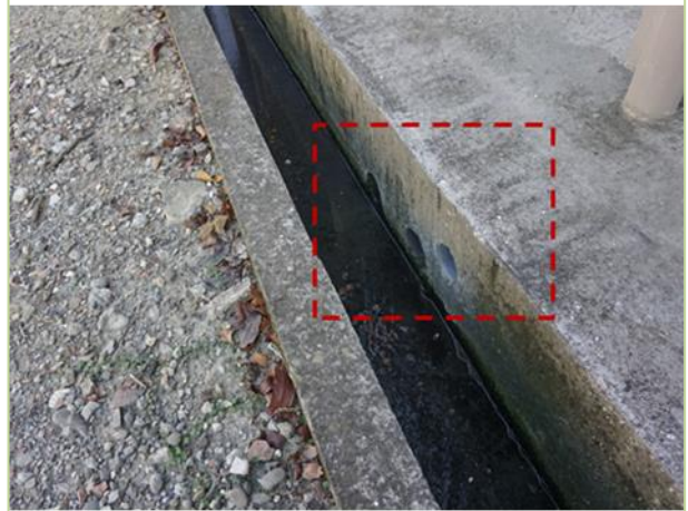
圖2 兵舍側溝排水不定時產生積水 資料來源：作者自行拍攝。
