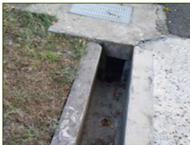
圖20 陰井水溝無積水現況圖 資料來源：A1營區提供。
