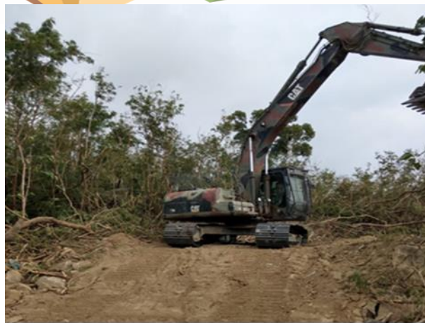
圖36 挖土機實施楓港陣地進出路整地 資料來源：作者自行拍攝。
