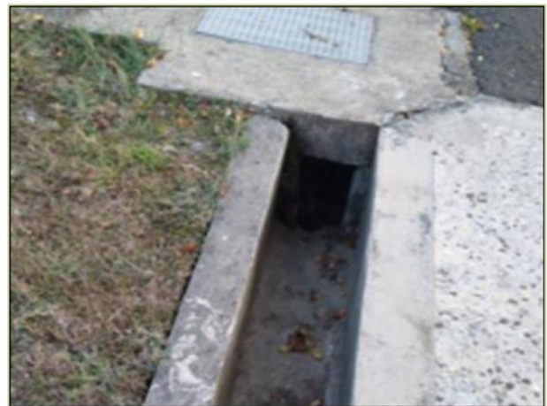
圖20 陰井水溝無積水現況圖 資料來源：A1營區提供。
