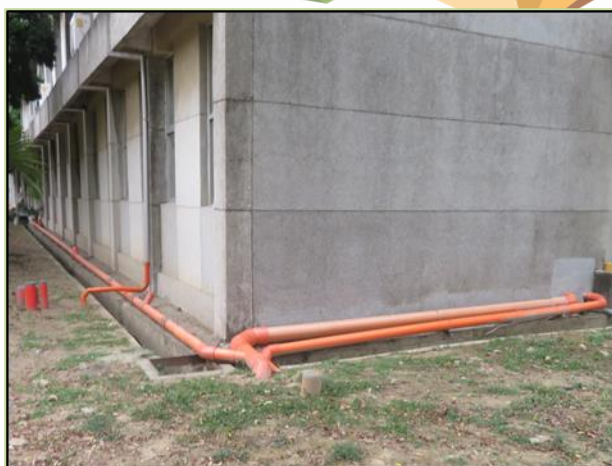
圖21 明管接戶管搭接 資料來源：A1營區提供。
