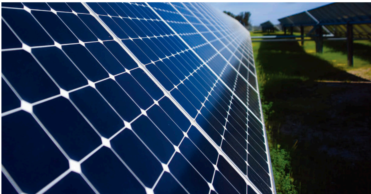
2018年，加州范登堡(Vandenberg)空軍基地裝設2,800萬瓦的太陽能光電陣列。此陣列供應基地35%的電力，而且不易遭受網路攻擊。(Source: USAF/ Clayton Wear)
