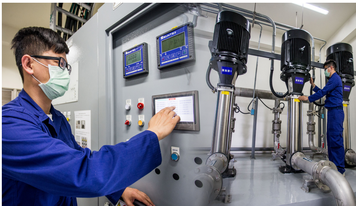
圖二 空軍第六混合聯隊過海沖淋純水製造暨加壓作業
