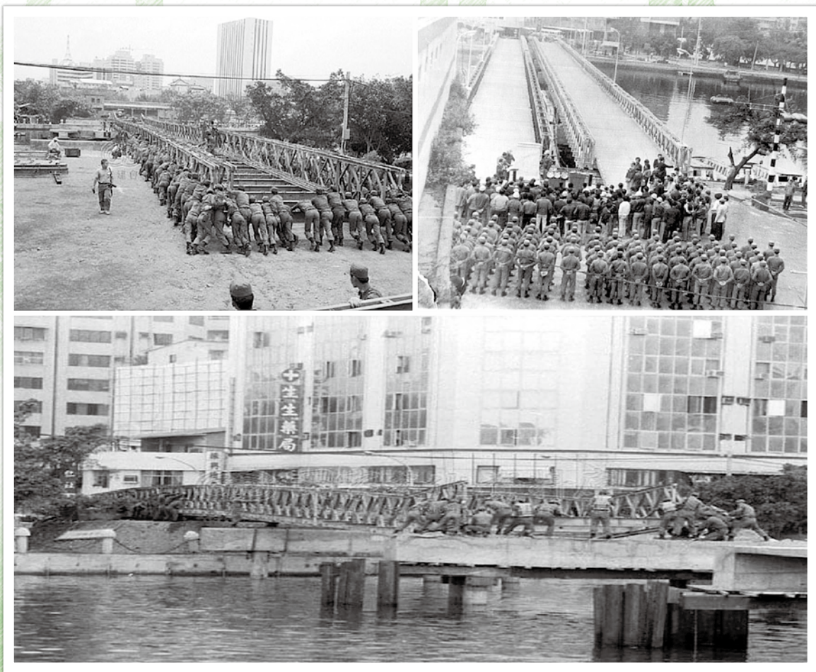
圖5 民國71年於高雄仁愛河架設桁橋實景照片
