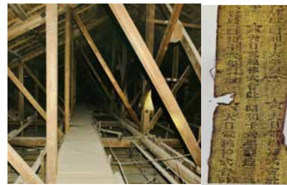
圖 26、27 鎮海樓的臺灣檜木屋樑以及繫留在上 76 年的祈福布條 資料來源：同註 27，頁 357、363 附圖 檢索日期：西元 2021 年 5 月 11 日
