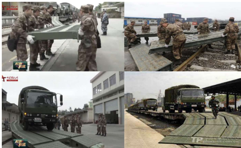
圖四 人工快速搭建站臺
