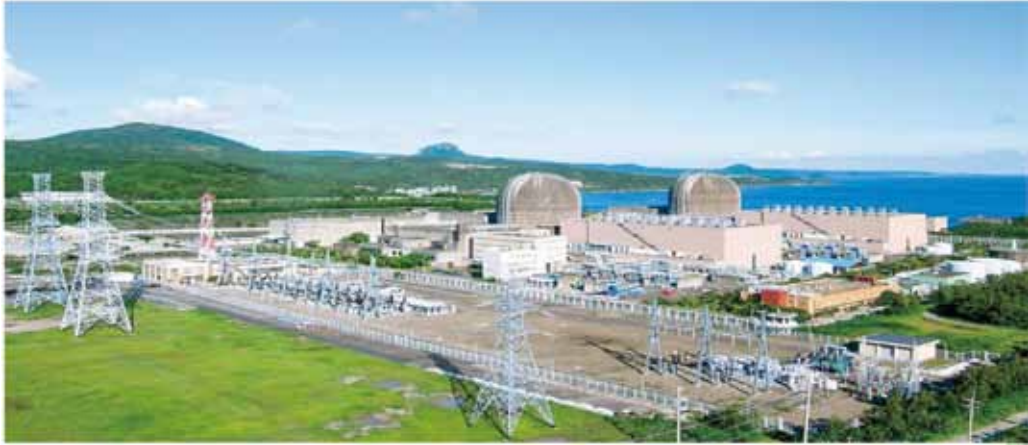
圖6 核三廠全景圖：台電提供
