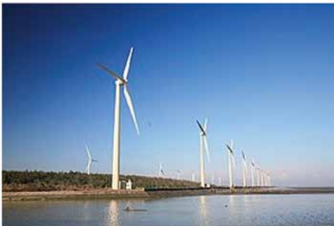
圖5 臺中港風力發電站
