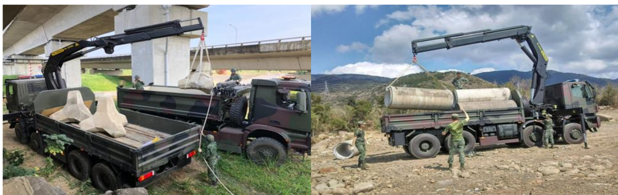
圖 2 多用途橋車吊掛作業(大型阻材-消波塊、涵管)
