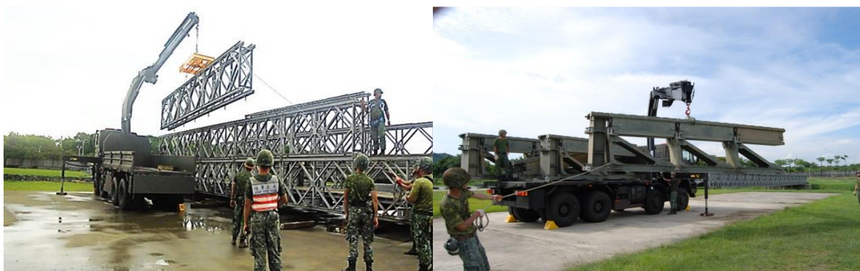
圖 3 多用途橋車吊掛作業(M2、MGB 機械協建)
