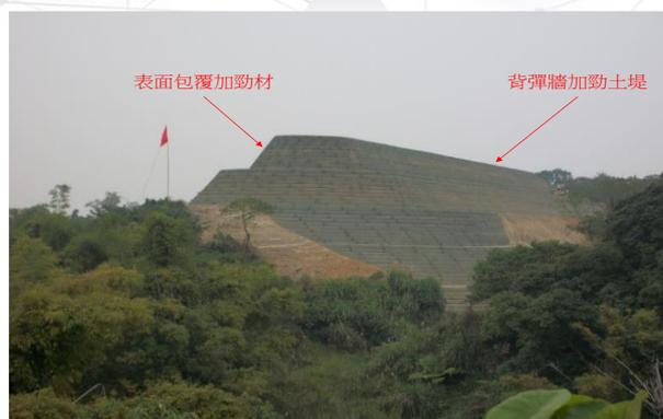
圖 4 戰車砲射擊訓練場背彈牆加勁土堤
