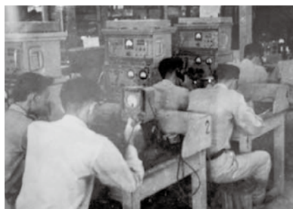
民國45年無線電機修護實況
