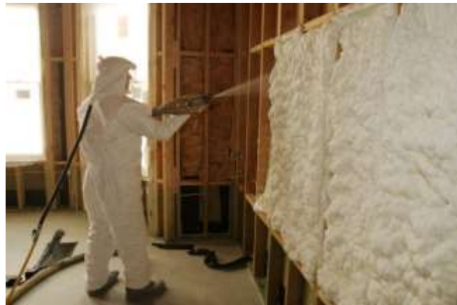
圖 8 作業人員噴灑聚氨酯泡沫填充劑
