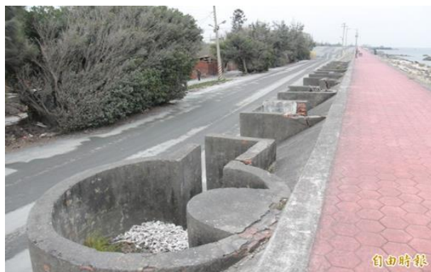
圖 22 海堤單兵掩體防禦陣地 資料來源：陳冠備，〈可惜！搶建台 61 線芳苑「反共長城」陣亡剩 1 座〉， https://news.ltn.com.tw/news/life/breakingnews/2677167 ，檢索日期：西元 2021 年 1 月 27 日。
