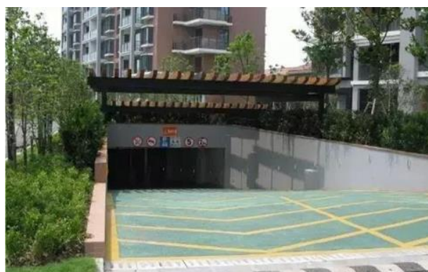
圖 23 汽機車庫出入口 資料來源：谷歌圖片搜尋引擎， http://www.google.com.tw/search/汽機車庫 ，檢索日期：西元 2021 年 1 月 27 日。
