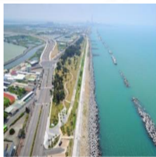
2. 築堤養灘工程
