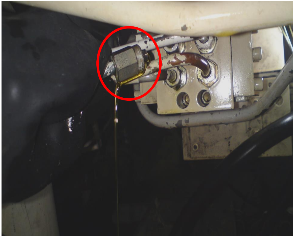
圖 17、回裝油管撤出液壓油
