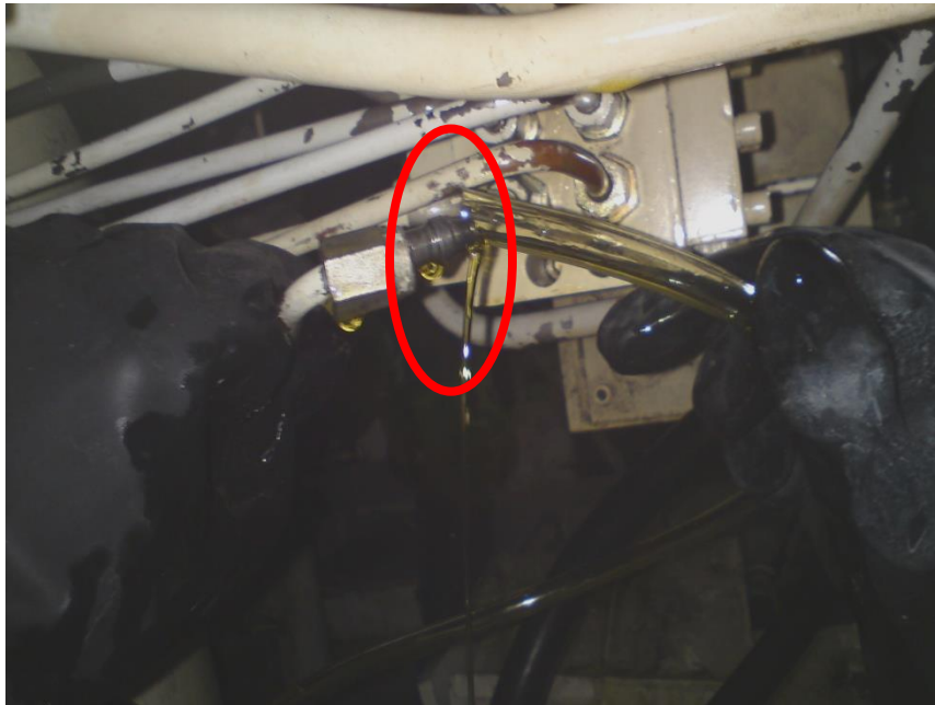
圖 16、取下透明軟管撤出液壓油
