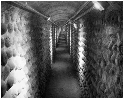
橫山戰備坑道四通八達，冬暖夏涼，內部皆由鵝卵石、鋼筋及混凝土打造而成，相當堅固。
