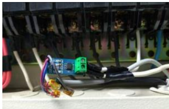
圖十六 電流感測器安裝於教室電箱位置圖
