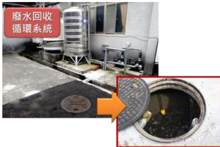
圖 13 廢水回收循環系統
