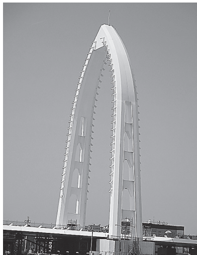
刻正興建中，用以銜連中科臺中基地和臺中經貿園區的「中科大橋」。
