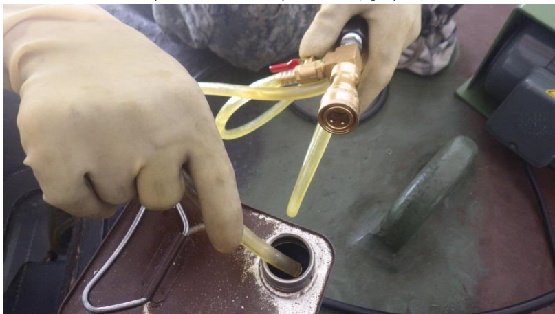
圖 51、油壓管內空氣排出
