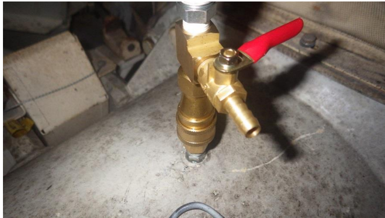
圖 59、連接快拆接頭
