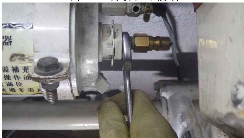
圖 53、安裝快拆接頭
