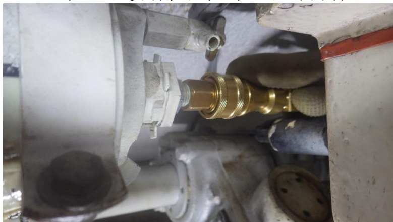
圖 54、連接輸出端油管於快拆接頭
