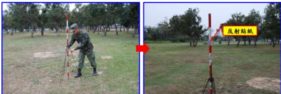
圖十四 於待測點整置標桿並張貼反射貼紙示意
