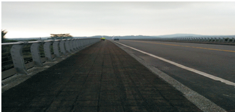
圖三、新威景觀大橋全長1735公尺，橫跨荖濃溪兩岸，看到了無盡的路
