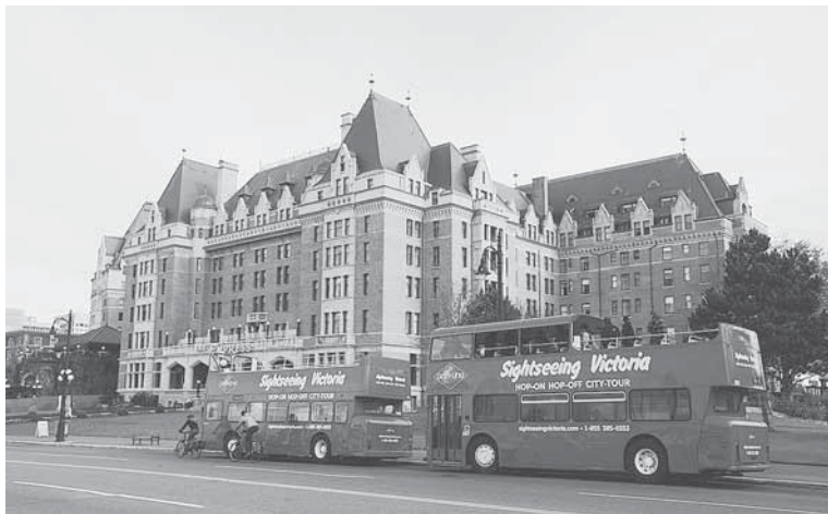
帝后飯店是港邊一棟壯觀的建築物。
