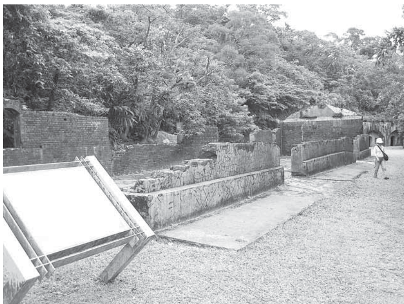
四腳亭砲臺旁以紅磚監造之營舍。
