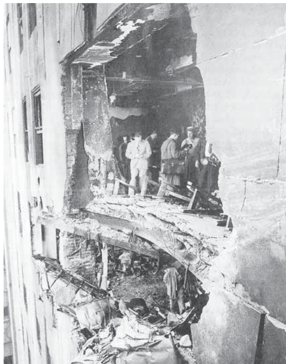
B-25將加強鋼骨結構之大樓撞出兩層樓的窟窿。
