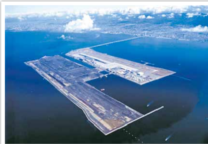
圖二 日本關西國際機場，是一座超大型浮體結構物，也是目前世界上最大浮動式海上機場
