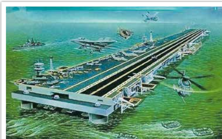
圖五 美國想建造一個排水量50萬噸，全長900公尺、寬90公尺、高60公尺，可搭載300~500架各種類型飛機的大型半潛型浮島式海上基地
