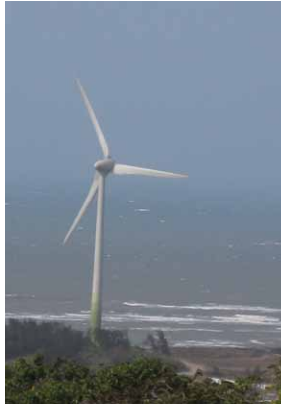
圖7 植設於通霄海岸邊的巨型風力發電機 (作者拍攝)
