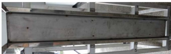
(e)裝置在槽底之不鏽鋼溫度循環片
