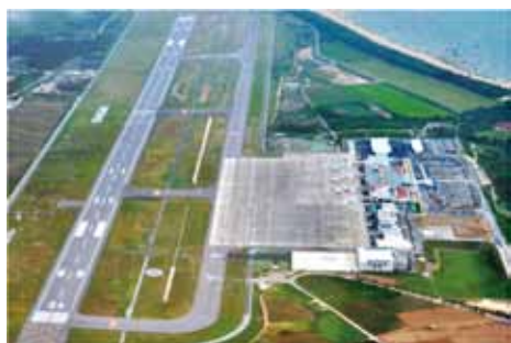
圖二 2013年3月7日全新落成的「新石垣機場」〈Painushima Ishigaki Airport〉跑道長2,000m、寬45m。〈本圖拍攝日期為2013年3月10日〉
