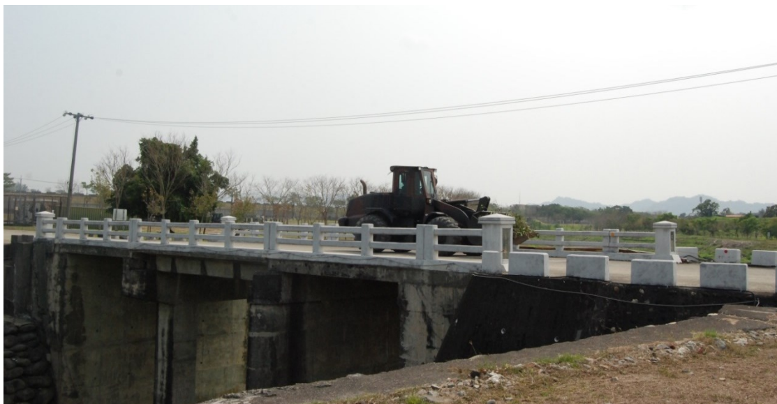
圖七 陸軍工兵訓練中心四營區中之大道橋
