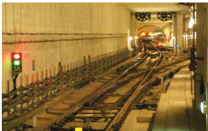
圖二 臺北捷運新莊線地下行車隧道
