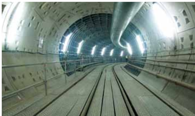
圖六 高雄市345KV地下電纜管道中華路段潛盾隧道
