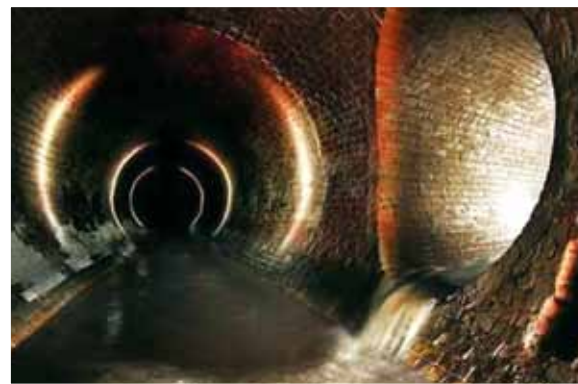
圖十三 錯綜複雜的地下水道，直徑達2~3公尺，可供人員通行
