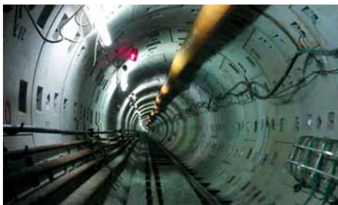
圖八 高雄市小港區中林路污水主幹管新建工程，污水主幹管內徑2公尺，總長6,246公尺
