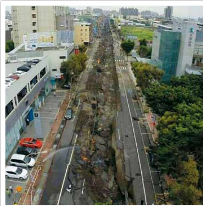
圖十一 高雄市2014年7月31日深夜發生氣爆意外，造成道路底下的地下排水箱涵嚴重損毀
