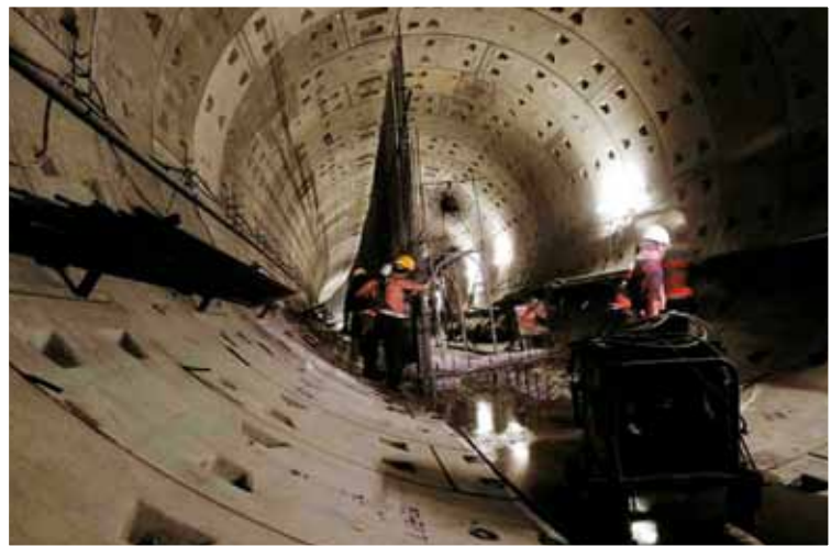
圖五 臺北捷運信義線電力、電信、自來水共同管道施工情形
