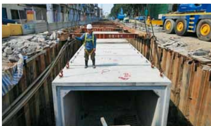
圖七 高雄市凱旋路新建中的地下排水箱涵，內徑3~3.5公尺，總長3,855公尺
