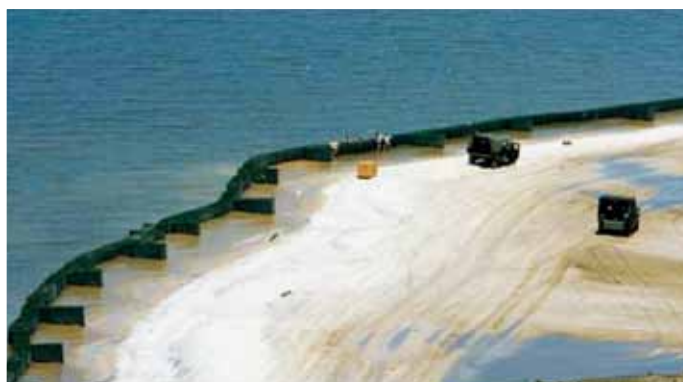
圖八 墨西哥灣漏油事件之攔油牆
