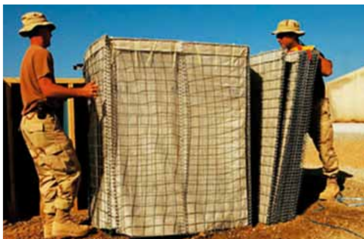
圖五 「組合式掩體」兩人設置作業
