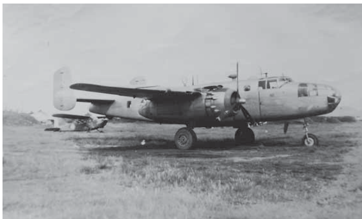
B-25改成偵照用的F-10型機，當時由於P-38雙引擎沒教練機，故用B-25雙引擎機來代替教練機。
