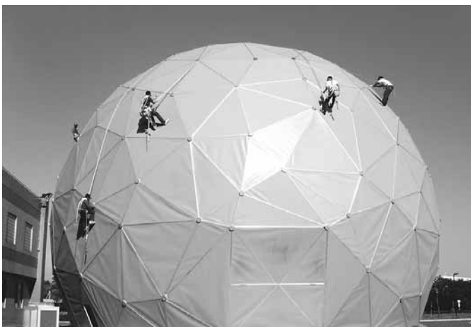
執行TPS-117機動雷達天線罩封膠作業。
