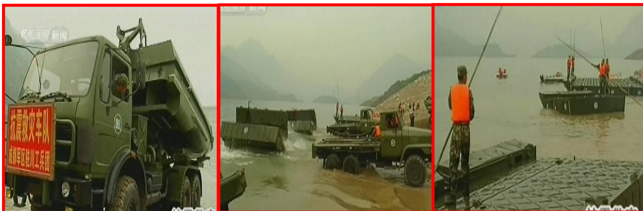
圖八 共軍工程兵舟橋團架設門橋實施漕渡
