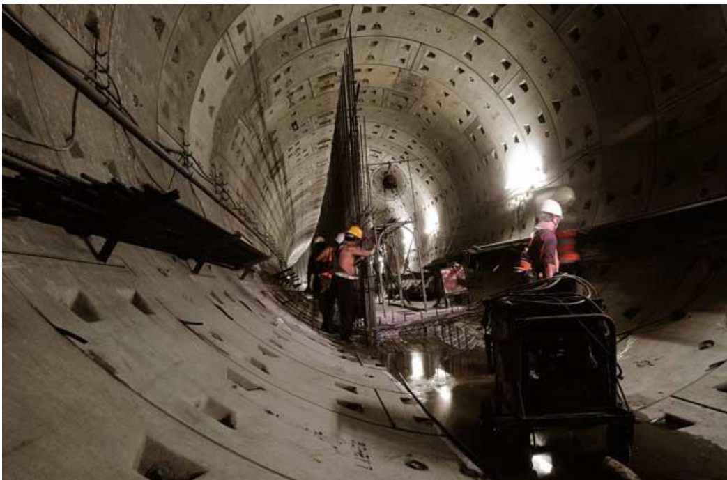
圖 5：臺北捷運信義線電力、電信、自來水共同管道施工情形
