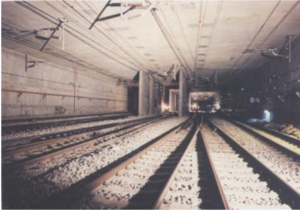
圖 3：臺北市鐵路地下化工程。
