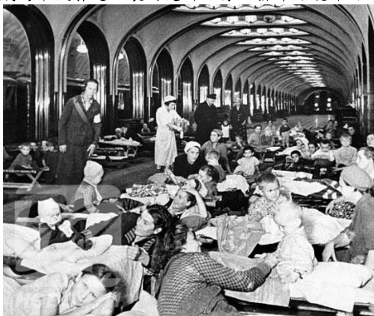
圖 10：二次世界大戰期間，蘇俄莫斯科地鐵隧道成為市民躲避空襲的處所，有效發揮防護作用。
