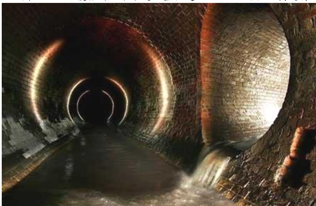
圖15：錯綜複雜的地下水道，直徑達2~3公尺，可供人員通行
