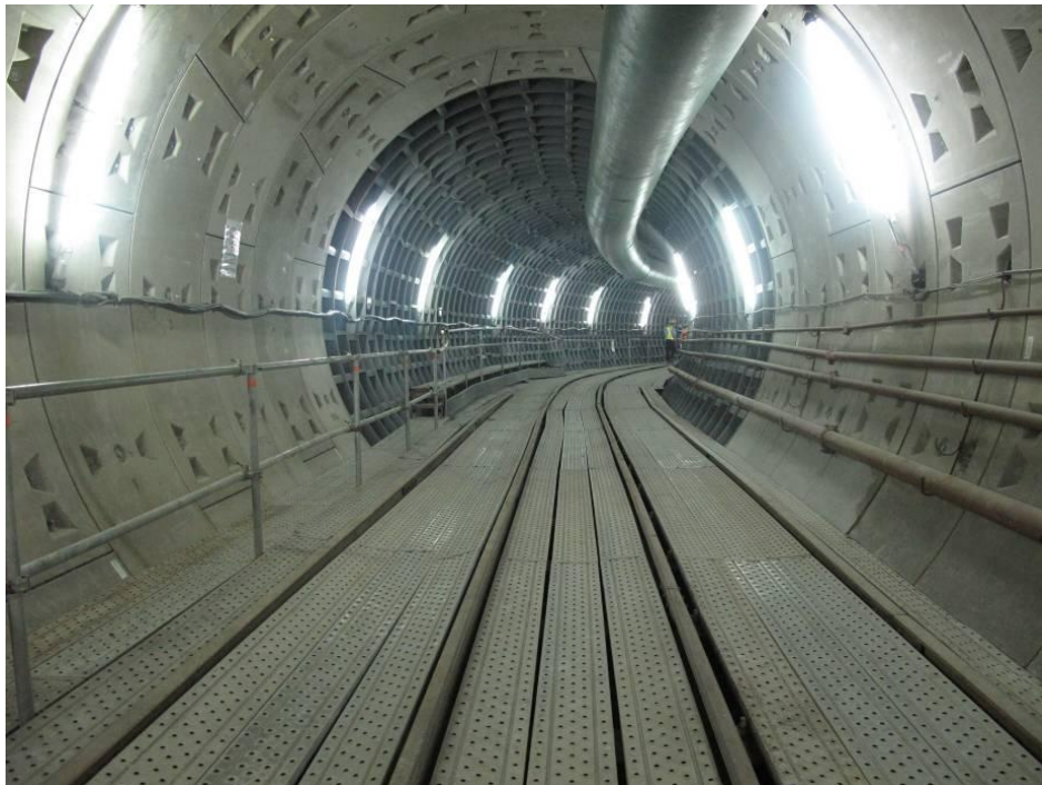
圖 6：高雄市 345kv 地下電纜管道中華路段潛盾隧道
