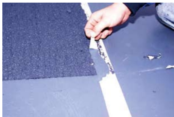
圖十五 待塗料完全凝固可供行走之後，即可將原先覆蓋的膠帶拆除
