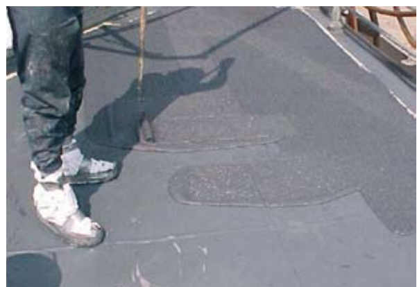
圖十三 鋪設防滑塗料時須遵從一定的方向性，如此才能兼顧防滑效果及美觀 資料來源：American Safety Technologies， http://www.astantislip.com/
