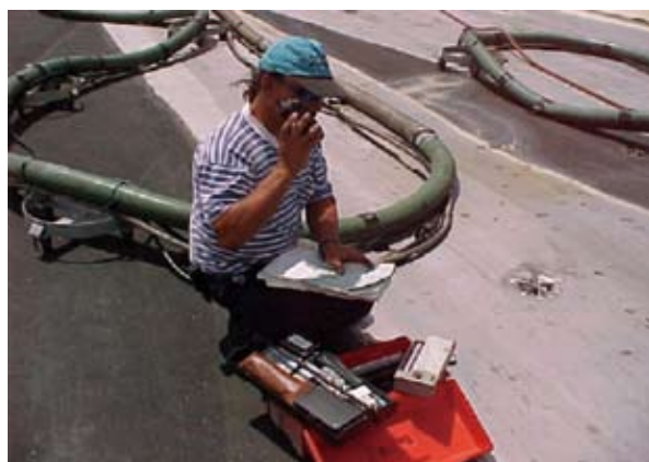
圖五 鋪設時嚴密監控環境狀況，對於塗料使用壽命有關鍵性的影響
