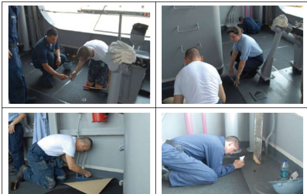
圖二一 胡蜂號的人員正進行P&S Nonskid甲板鋪設
