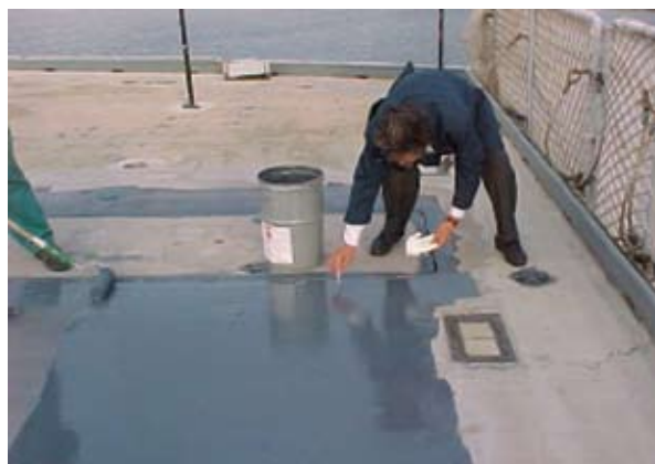
圖六 底漆濕膜厚度的測量必須在上漆後立即進行，以免因溶劑揮發而造成漆膜發生收縮現象，右圖為常見的濕膜厚度計
