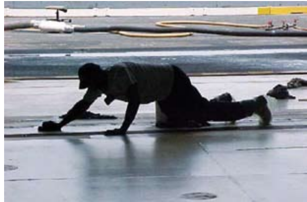
圖八 人員於鋪設防滑塗料時，應著鞋套以避免破壞及汙染底漆
