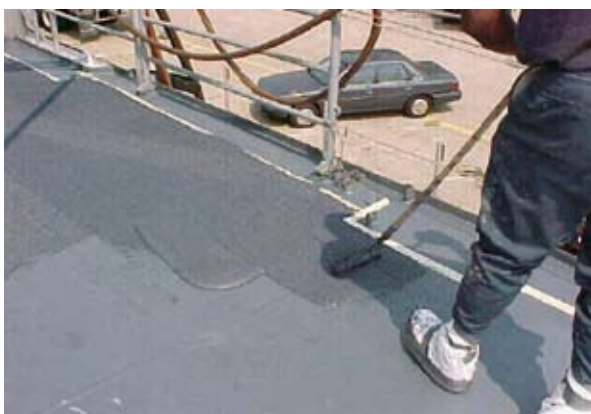
圖十三 鋪設防滑塗料時須遵從一定的方向性，如此才能兼顧防滑效果及美觀 資料來源：American Safety Technologies， http://www.astantislip.com/
