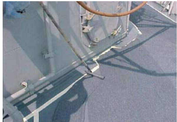
圖十二 滾刷防滑塗料須使用適當的滾筒，才能拉出最佳的防滑效果
