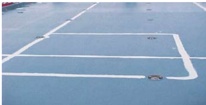
圖七 良好的底漆塗裝對於防滑塗料的壽命相當關鍵
