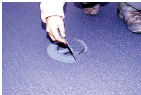
圖十五 待塗料完全凝固可供行走之後，即可將原先覆蓋的膠帶拆除
