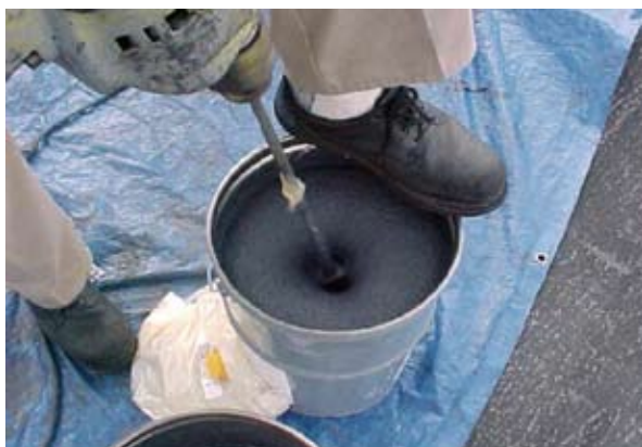
圖十一 防滑塗料使用前應予以適當攪拌混合
