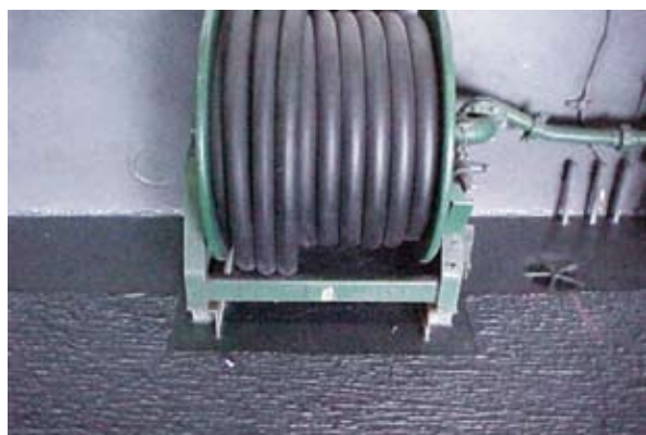
圖十六 完工後的防滑砂道即可準備面漆塗裝
