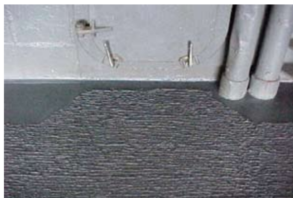
圖十六 完工後的防滑砂道即可準備面漆塗裝
