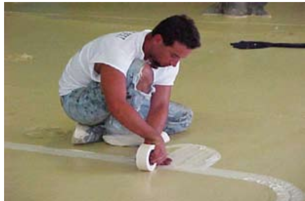
圖九 飛行甲板十字樁及艙蓋部分於鋪設前須以膠帶覆蓋
