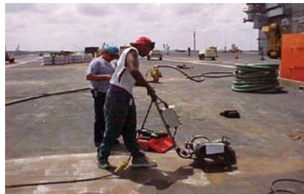
圖二 良好的甲板除銹工作是邁向成功塗裝的第一要件
