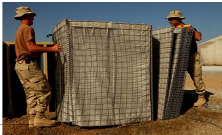
圖五 「組合式掩體」兩人設置作業
