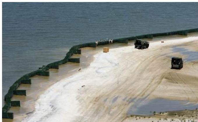
圖八 墨西哥灣漏油事件之攔油牆
