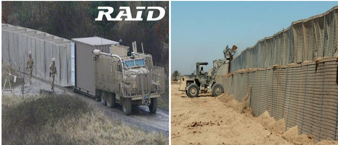
圖十九 車輛配合機具構築
