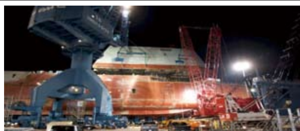
圖三 DDG-1000甲板船艙與船體結構吊裝接合
