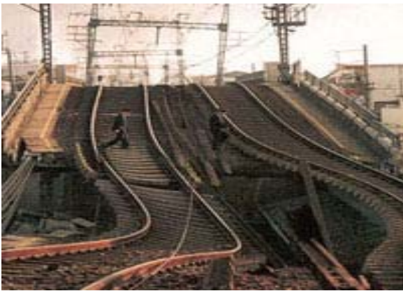
圖五 阪神地震災情 1-鐵路新幹線倒塌。(資料來源：1995 年日本阪神地震簡介， http://www.huaxia-ng.com/web/?action-viewnews-itemid-4931 )
