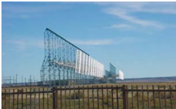
圖二c AN/FPS-118雷達發射天線陣列
