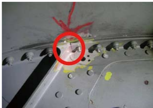
圖一 座艙段結構損傷圖
